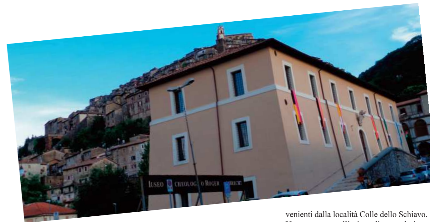
Il Granaio Borghese, l'edificio che ospita il Museo archeologico "Roger Lambrechts". All'interno di questo edificio c'è la sala consiliare e una sala convegni. Nel piano terra insiste il museo dedicato allo strumento antico
